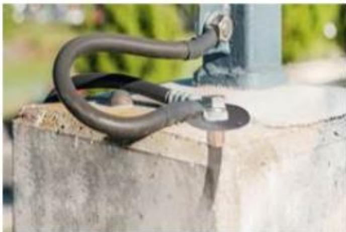
**Рисунок 1 Глухие проводники**
